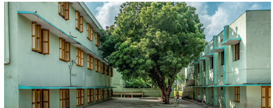
Gebäude des Hilfswerks «St. Antony's Foundlings» in Kanji.
